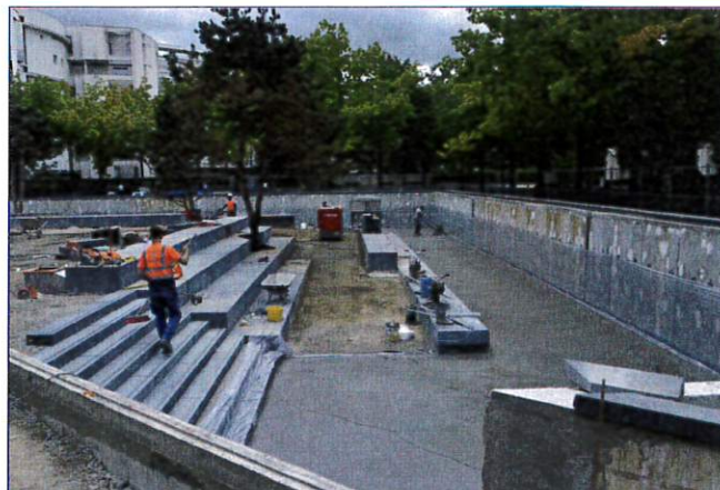
Construction du monument en hommage aux OPEX
